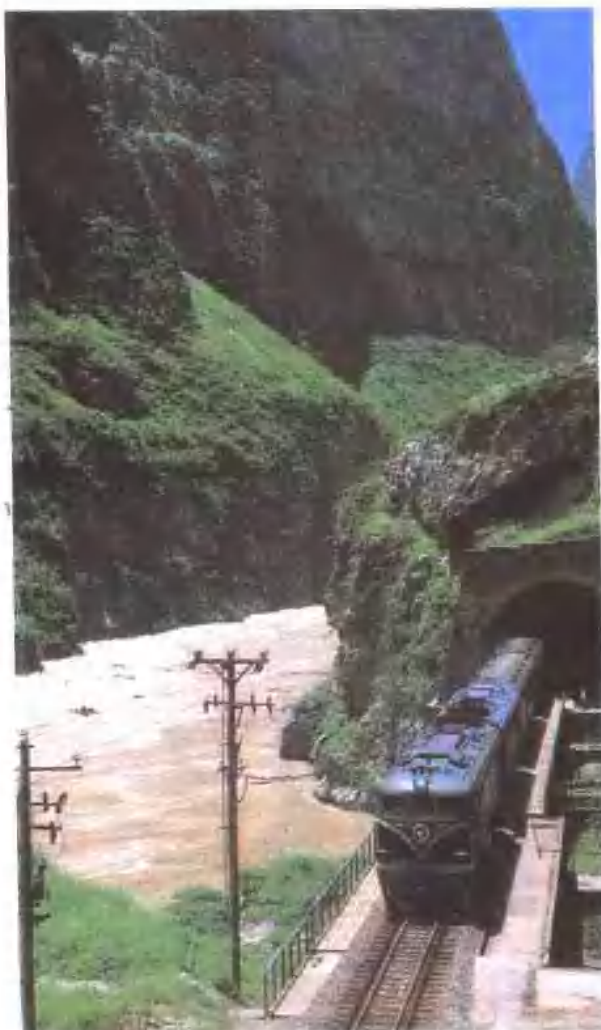
彩 14 在成昆线上穿过隧道的火车
