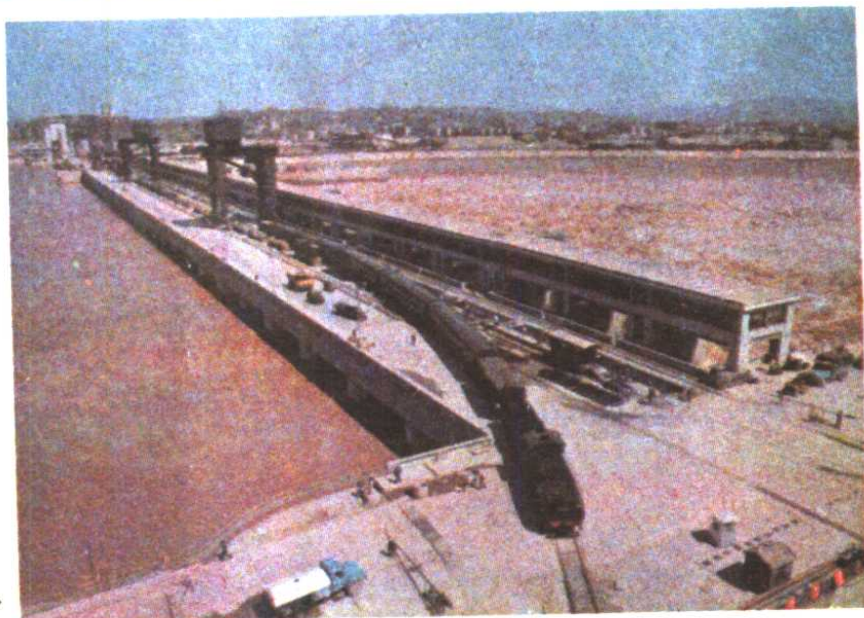
葛洲坝水利枢纽工程 ▶
