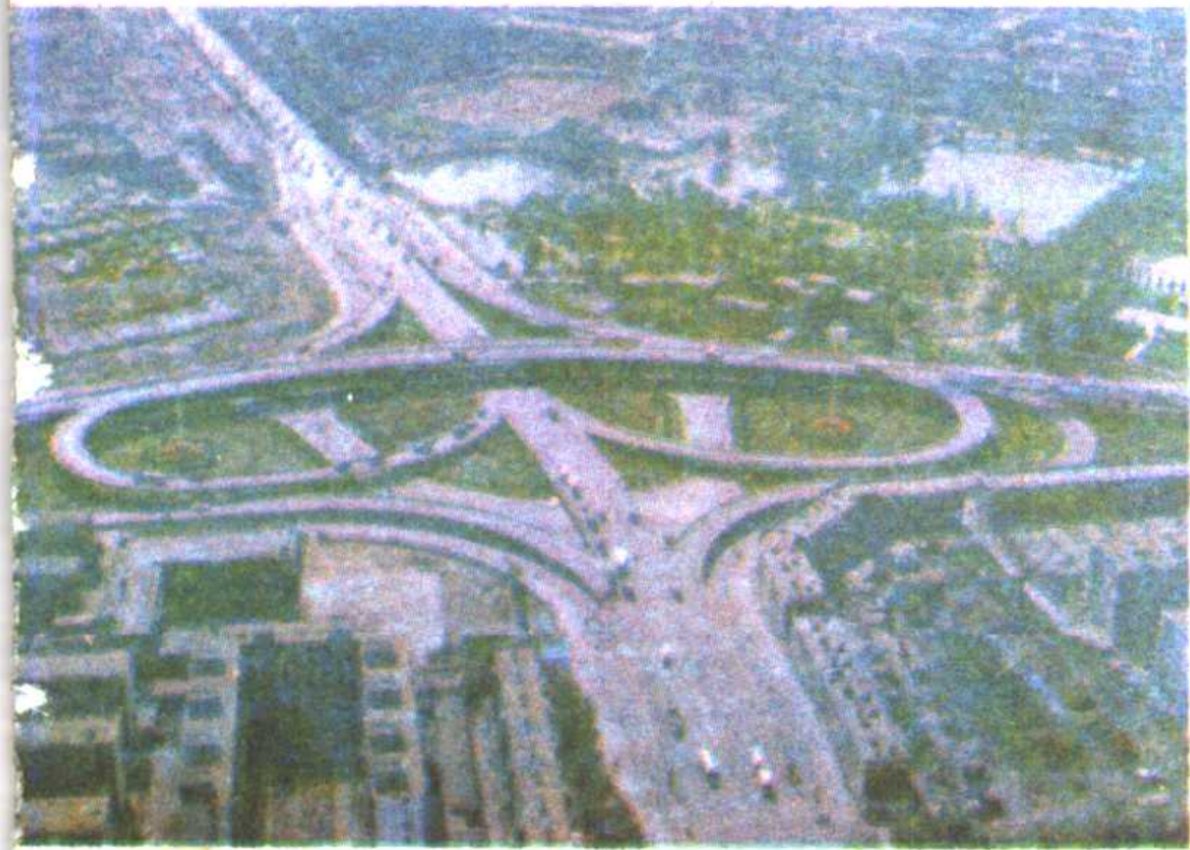
◀ 天津蝶式立交桥
