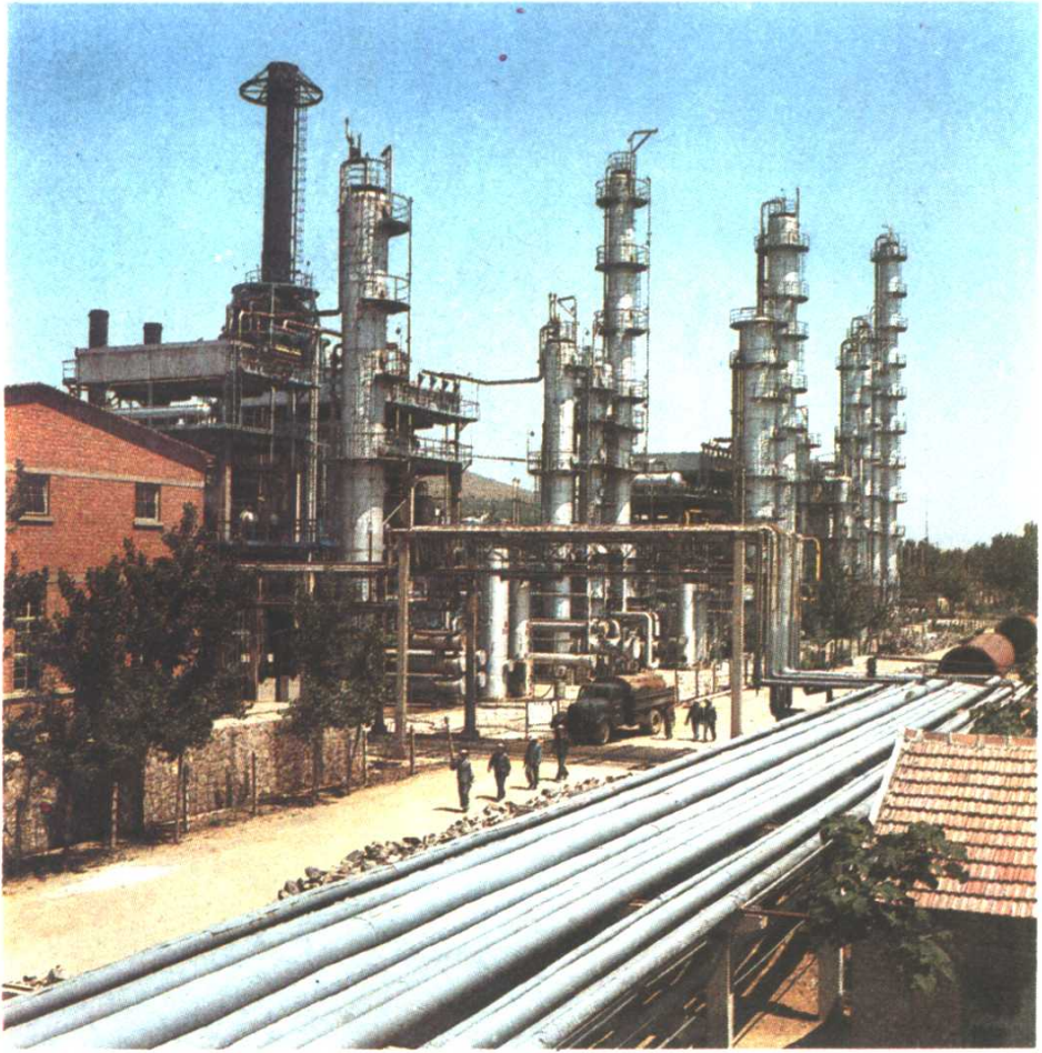
胜利油田石油化工厂一角
