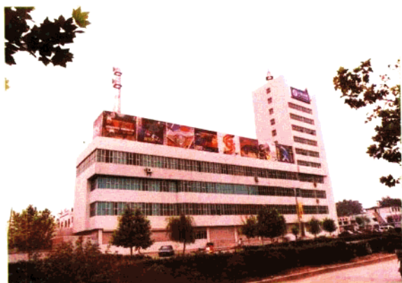
1.市邮电大厦 2.市邮电大厦侧面 3.电视电话会议室 4.市局微波铁塔
