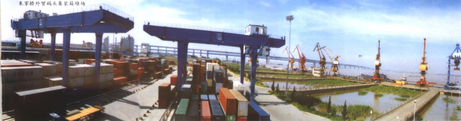
朱家桥外贸码头集装箱堆场
