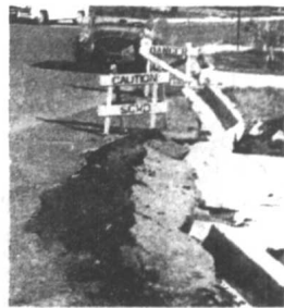
粘土受到混凝土車道的壓力往旁滑動；街道及其護角發生翹曲現象。 七圖顯示建築時對土壤應加以考慮之重要性
