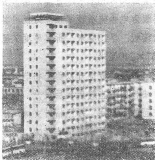
上海陆家宅大模板施工
