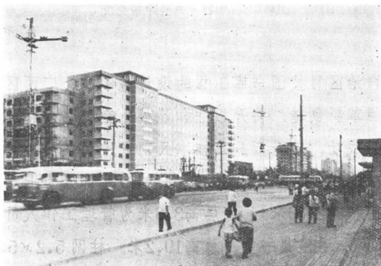
北京前三门大模板施工
