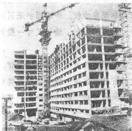
上海华盛路框架挂板住宅
