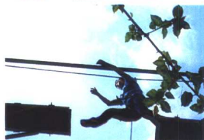
空中跨越断桥
