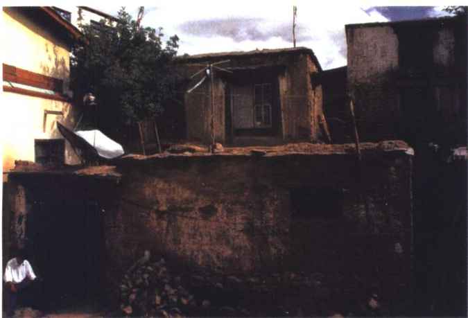
1959年西藏实行民主改革后，人民政府出资为鲁固居民修建了住房。从1984年起，又逐步对居民的住房进行改造。这是改造前的旧房子。
