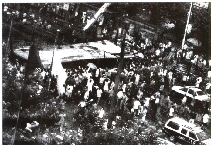
◆ 某市十多米长的广告牌倒塌压扁了2辆汽车的事故现场
