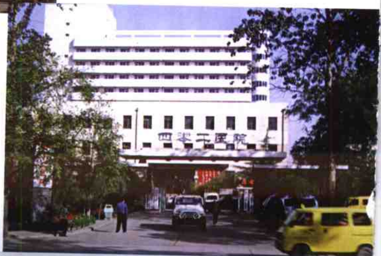
电子工业部四〇二医 院新病房楼
