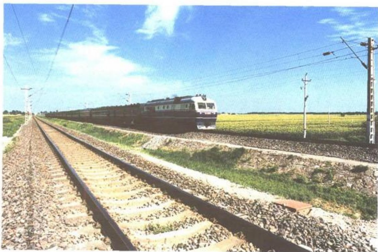
●京秦电气化铁路横跨三河
