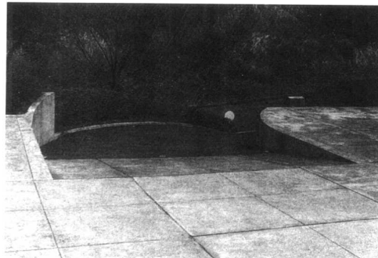
广场的混凝土路面
