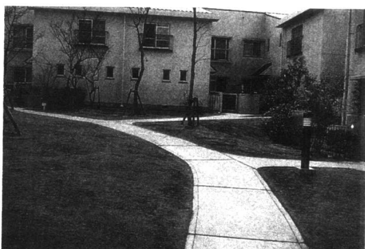
园路的混凝土路面
