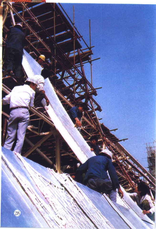
28 EPS 曲面夹芯板施工
