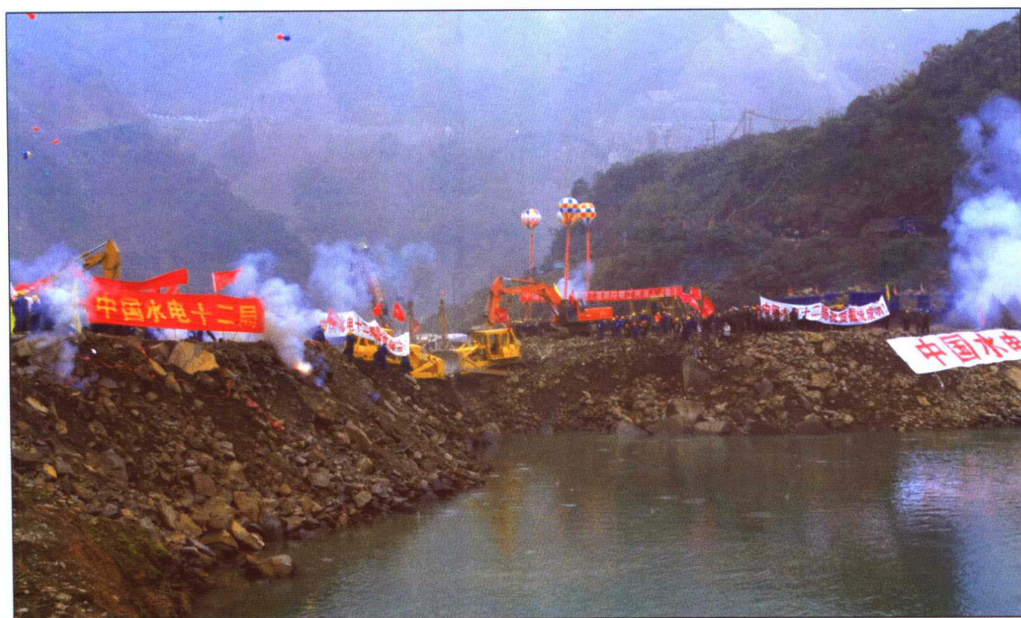
◆ 2002年11月23日，四川省紫坪铺水利枢纽工程截流
