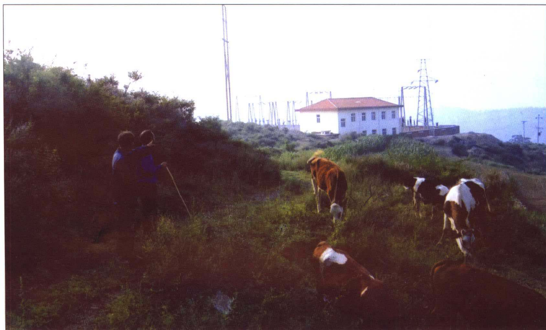
◆ 农村电网改造提高了农村用电质量，农村电价大幅度下降，农村用电水平迅速提高。图为农网改造中2002年新建的山西省晋城东背变电站
