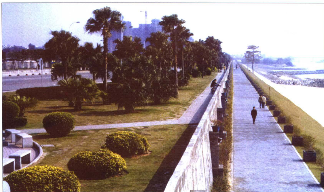
◆ 2002年12月26日，福建千公里江堤建设全面竣工。图为福州市江滨大道防洪堤 兰伟龙 摄
