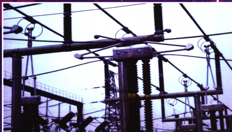
GW6A-252D(W)/2000、 2500、3150-40、50型戶 外高壓隔離開關
