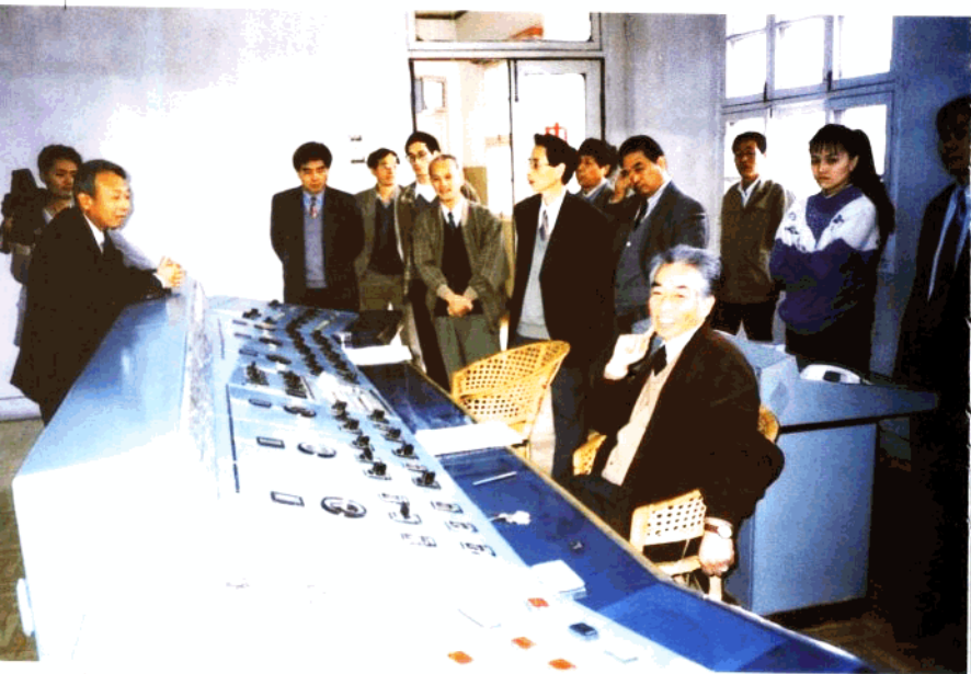
▲ 1996年11月16日，电力工业部副部长汪恕诚（图中坐者）在电站中央控制室
