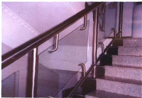
彩图 7 夹板式玻璃栏板
