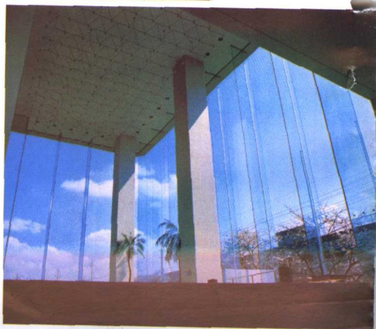
彩图 3 抗风、抗震、抗冲击性能优越的吊挂式全玻璃幕墙
