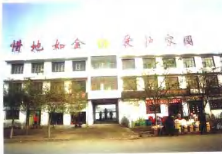
赵县土地局办公大楼
