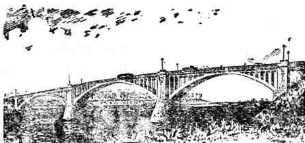
圖5 鋼筋混凝土拱橋（1953年）
