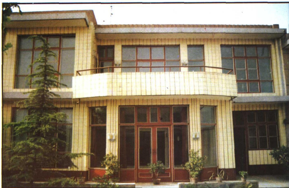
◀ 郊区农民住宅楼
