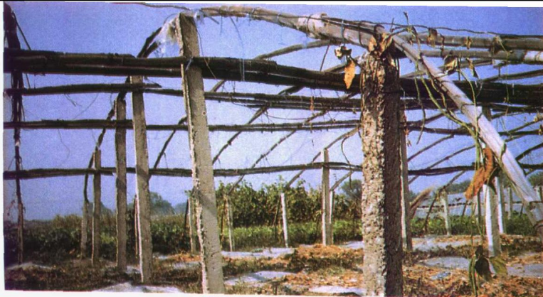
八排水泥柱竹拱架安装图 ▶
