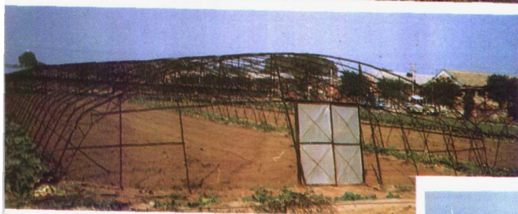
圆钢焊接半人字拱架大棚外形 ▲
