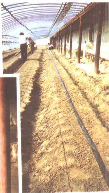
砖墙、钢柱、管 架组架式加温温 室铺设滴灌管 ▼
