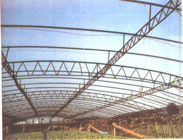
圆钢焊接人字架大棚棚头设置 ◀
