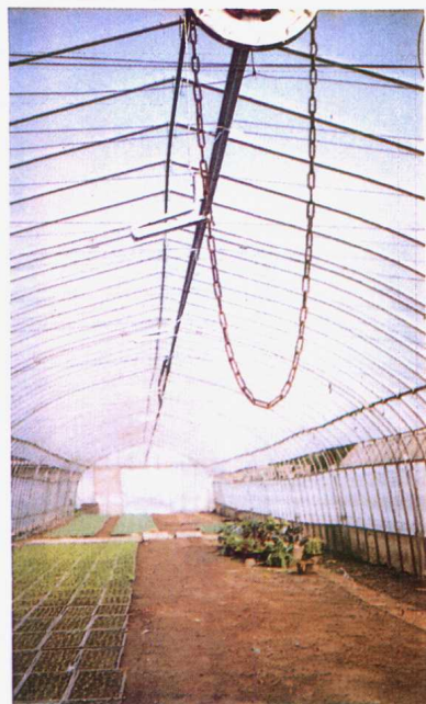
▲ 组装式大棚的二道幕装备中托架和长拉杆设置
