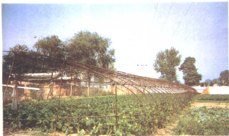
圆钢焊接人字架大棚棚头设置 ◀
