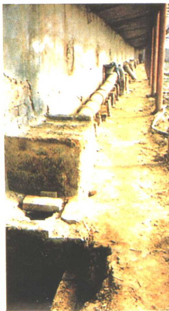
◀ 砖墙、钢柱、管架 组装式加温温室卷起蒲 苫放置部位和上风口
