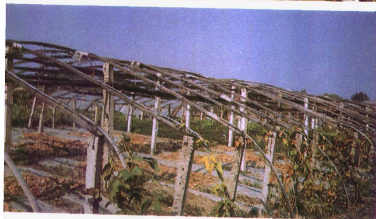
六排柱式混合结构大棚骨架组装 ▶
