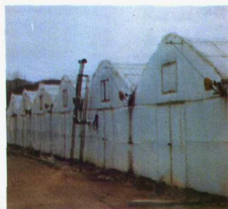
镀锌管架组装式连栋大棚外形 ▶
