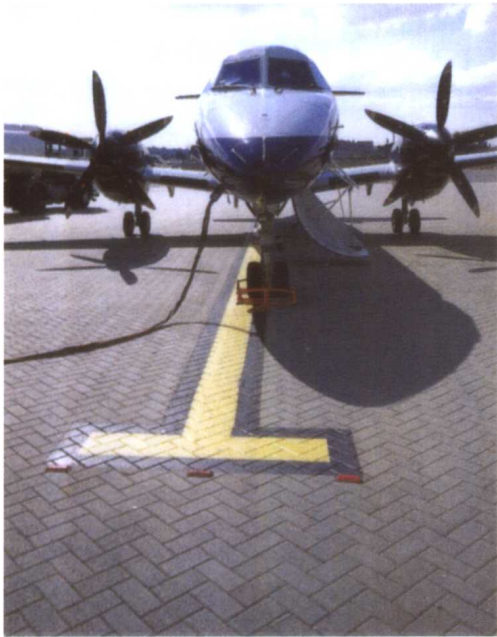
无刚性裂缝和轮陷之忧的地砖机场铺地
