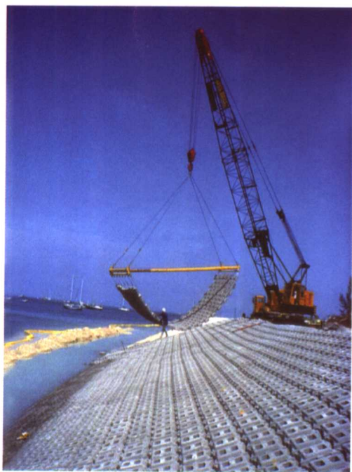
整体铺设铰接式护土砖水土保持系统
