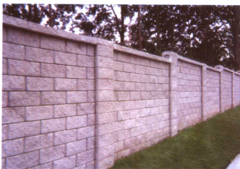
无砂浆砌筑干垒砌块围墙
