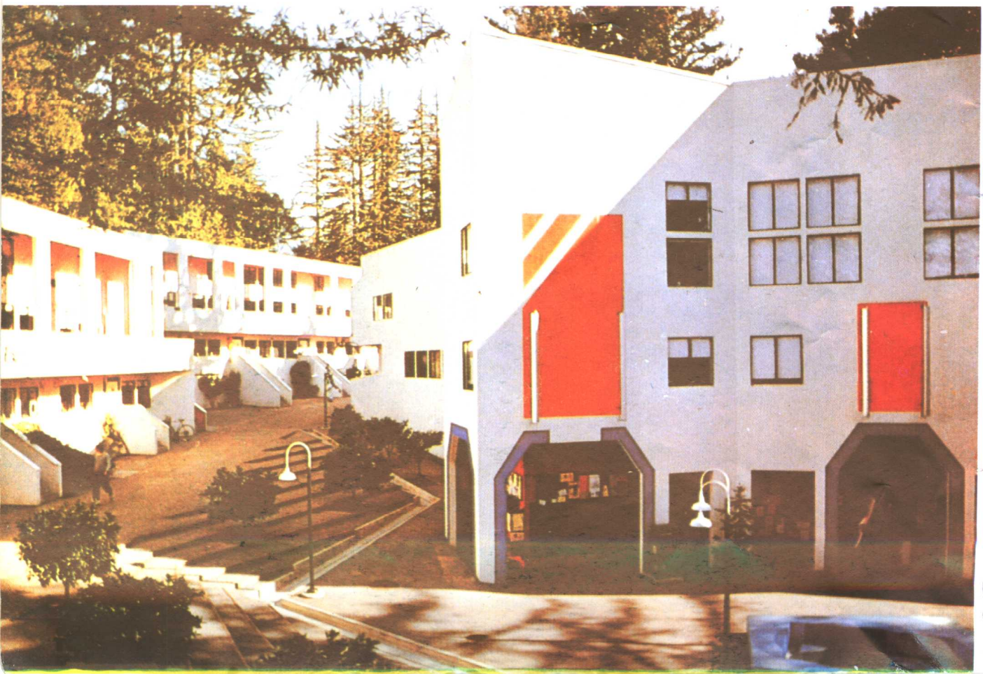
彩图 27 克雷斯格学院中进进出出的柱廊, 弯弯曲曲的空间构成, 高低起伏的地面组织, 丰富的光影变化, 这一切均为了摆脱追求“崇高”的旧俗, 并代之以亲切的形象
