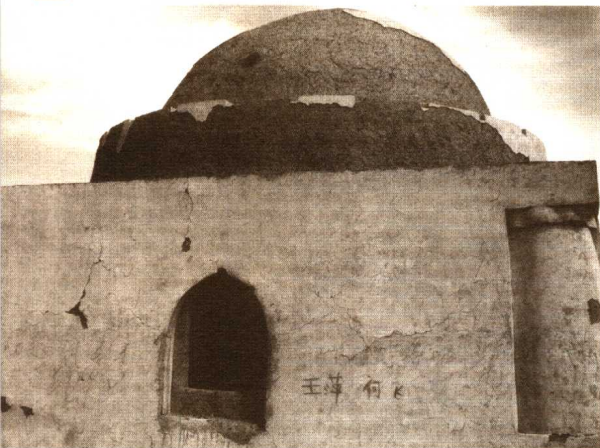
黑城城外西南角，有一座用土坯建造的圆顶清真寺。近年来此观看的游客逐渐增多，然而文物意识淡薄的一些游客在墙壁上乱涂乱写对这一古老的土坯建筑造成了一定破坏。
