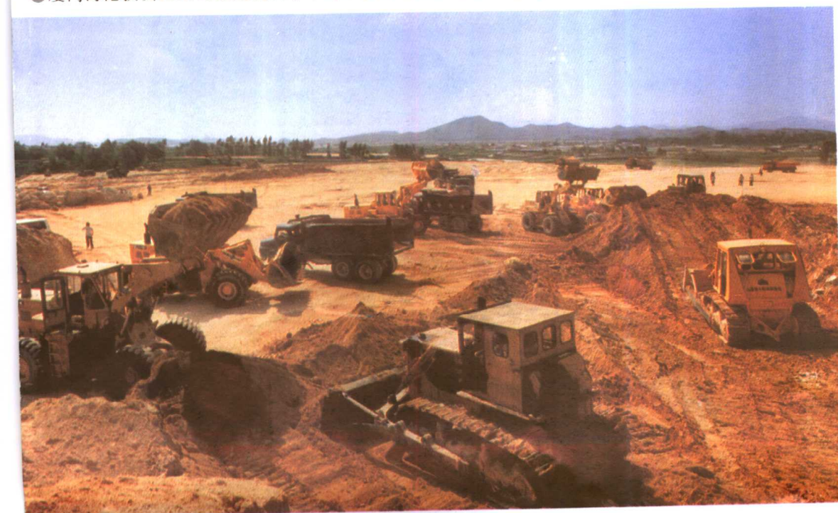
●海沧投资区到处可见热烈的施工场面
