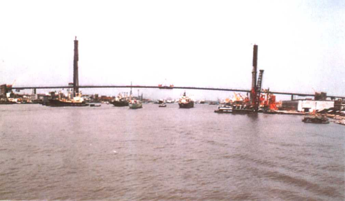
上海杨浦大桥主桥工程
