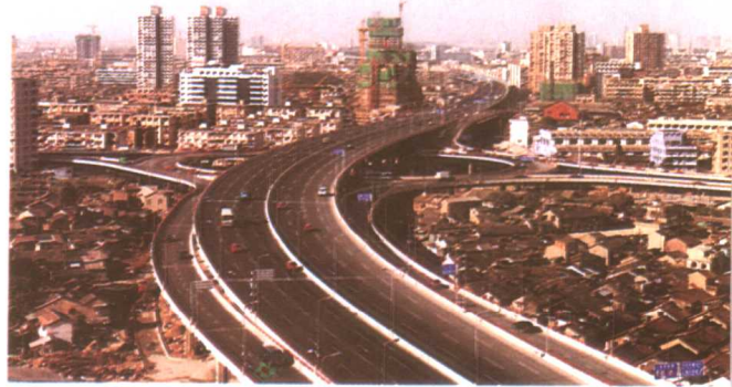
上海南北高架桥路
