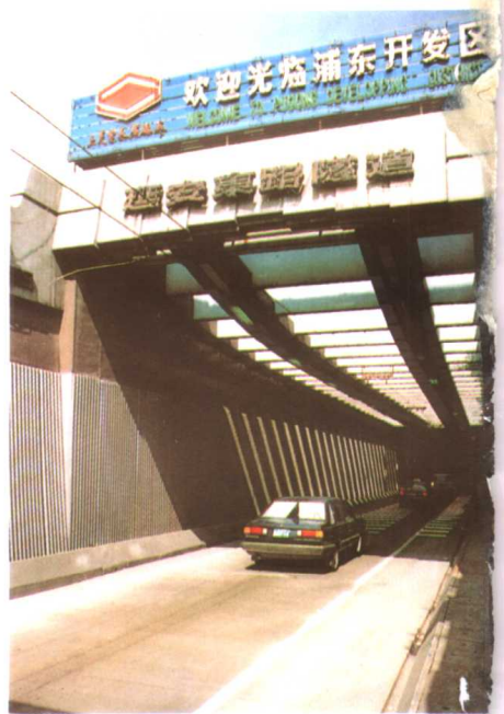
上海延安东路过江隧道
