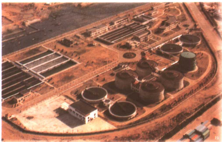
青岛海泊河污水处理厂全貌
