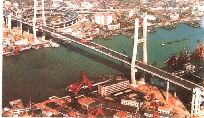
上海南浦大桥
