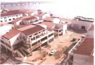
由E、D小区看鸭绿江大桥
