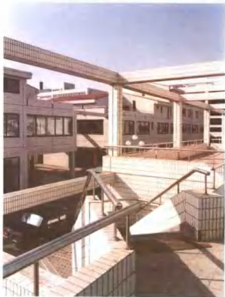
从B小区转角梯处看C小区
