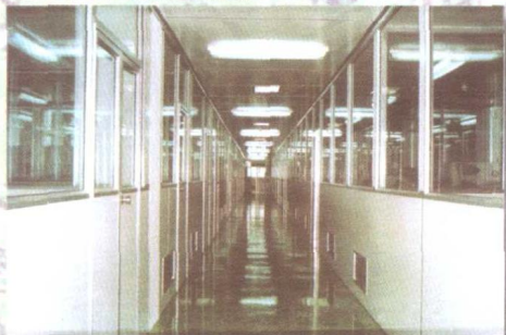
第一制药厂 GMP 车间人行通道
