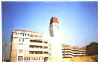
施工中的B、C座
