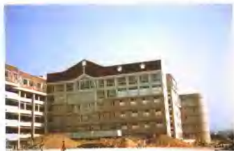
施工中的A座
