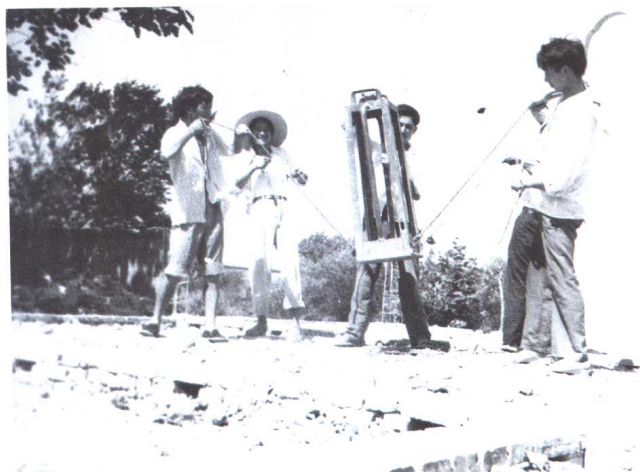
打夯号子(铁夯) 邵正才摄
