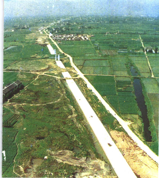
黄浦江上游引水 一期工程引水管渠
