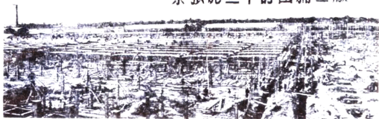
6. 1954年5月緊張施工中的石家莊二棉
