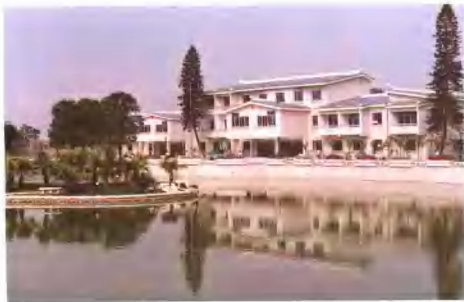
广西西路饭店十号楼
