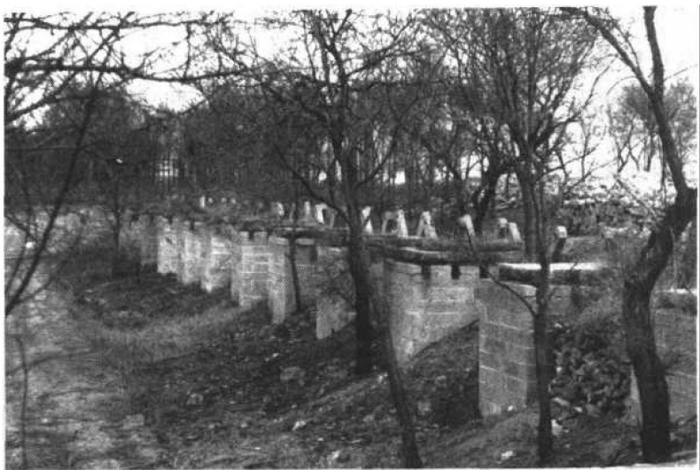
永定河右堤上金门闸遗址，建于清代。
