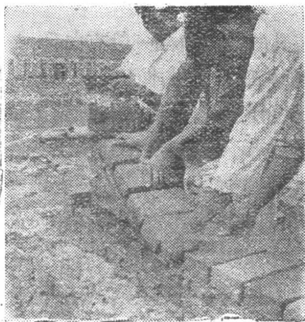
图 14 1 鋪磚鋪灰器操作方法示意图
