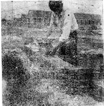
圖3 舀灰鋪灰器操作示意圖
