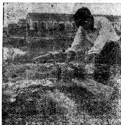
图 8 第一次抹灰后进行砌磚的姿势
