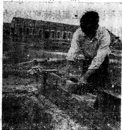
图 12 第三次抹灰后进行砌砖的姿势
