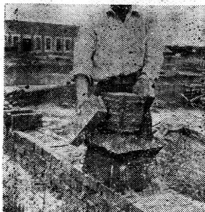
图 7 进行第一次抹碰头灰时的操作姿势
