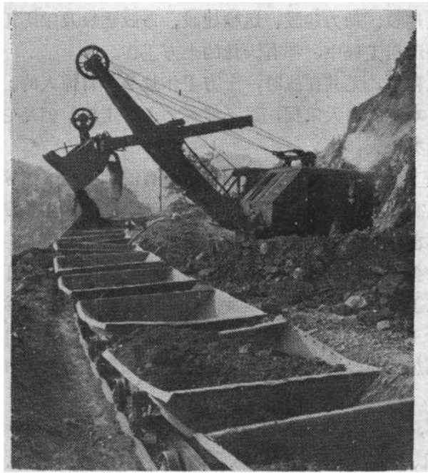
图 0—2 我国某建筑工程中应用挖掘机采掘建筑材料
