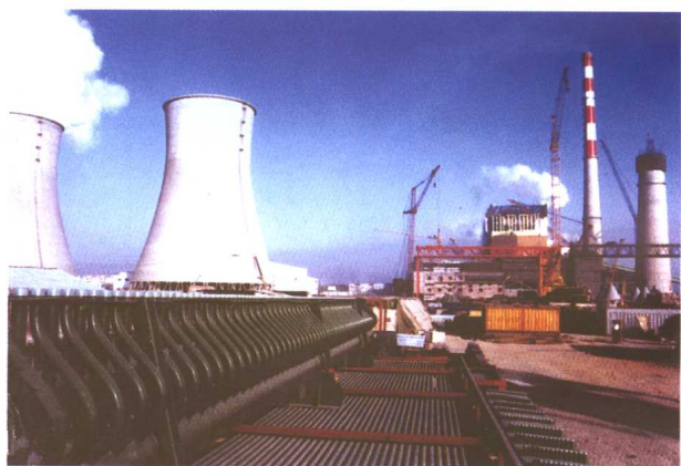
40. 宁夏石嘴山电厂扩建工程一号机组(30万kW)于2002年11月5日并网发电成功。
