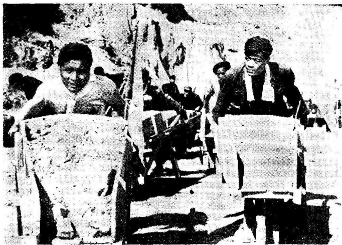
风南公路工地，第一連、第三連比武，三連連長在推土。
