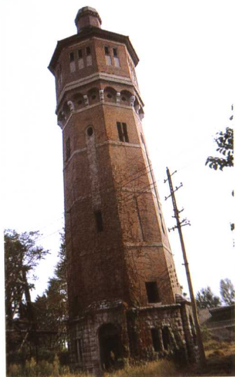
井陉煤矿皇冠水塔（清代）
