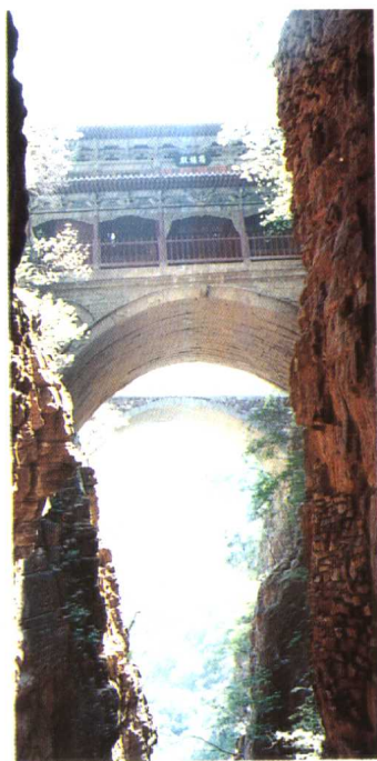
井陉苍岩山桥楼殿
