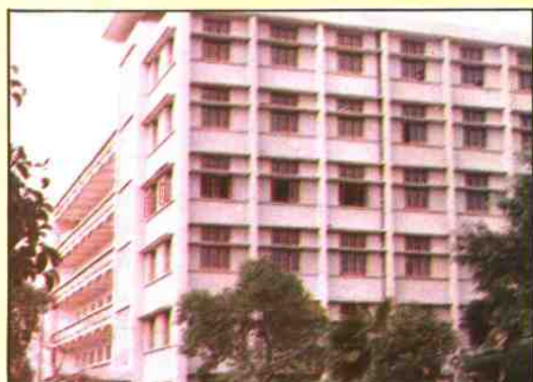
▲ 武汉市农业学校实验大楼
