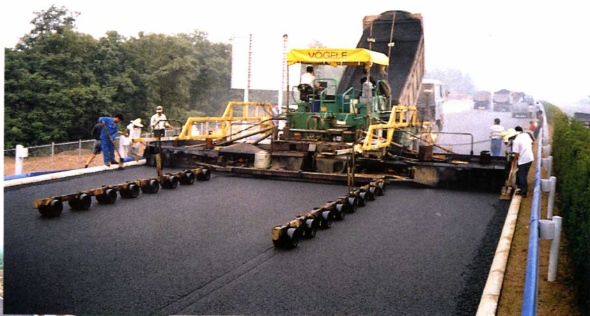
ABG 沥青混合料摊铺机在 进行路面铺筑
