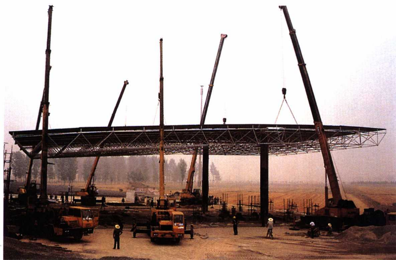
收费站大棚安装作业
