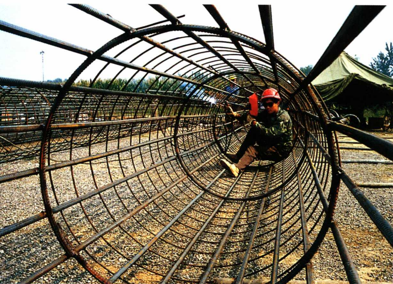
桥梁基桩钢筋笼绑扎作业
