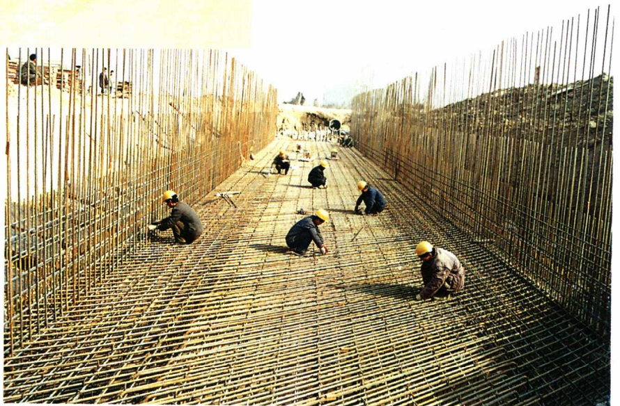
通道工程的钢筋绑扎作业
