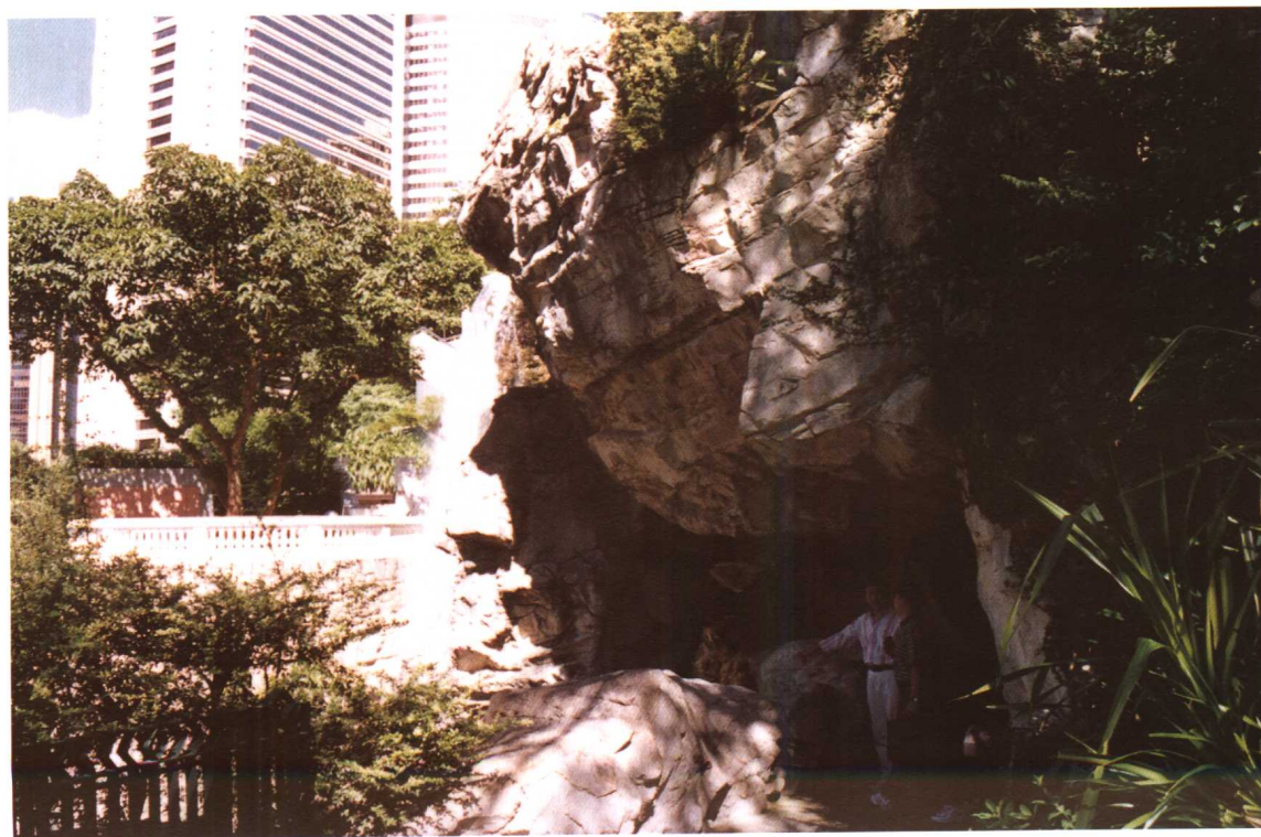
图 1-15 GRC 塑山，巨大的岩洞纹理真实，与地形相结合，自然、逼真
