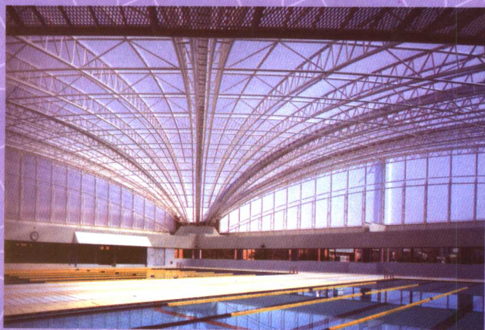
Mukogawa Gakuin 屋盖关闭内景
