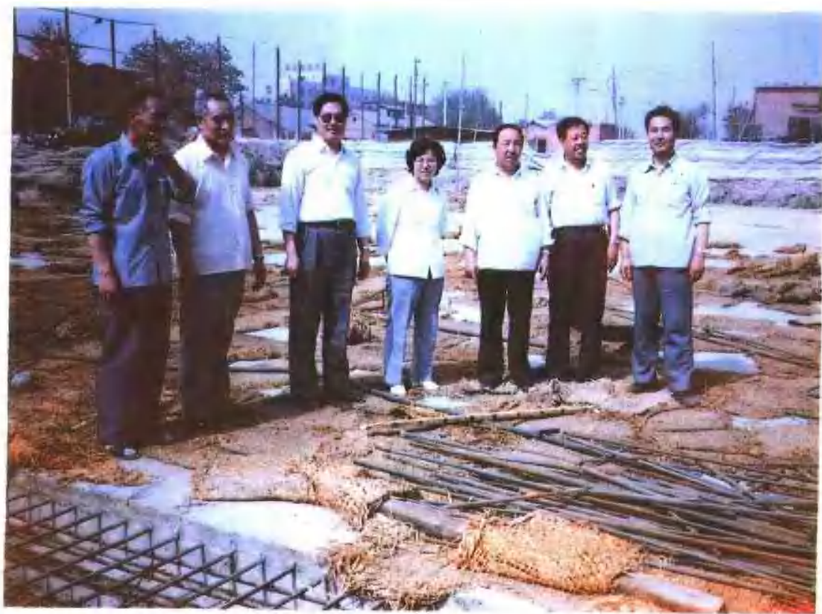
1988年7月，河北省财政厅厅长韩锡正（左三）视察石家庄火车站改造与建设情况。石家庄市财政局局长杨许坚（左二）、副局长周春发（右一）陪同视察施工现场。
