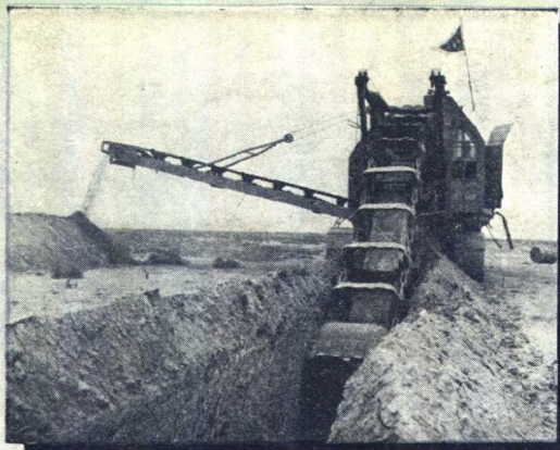
← 我國第一條輸油管綫 (從克拉瑪依到獨山子煉 油廠),正在加速進行鋪設 工程。這是大型挖溝機正 在挖輸油管溝。
