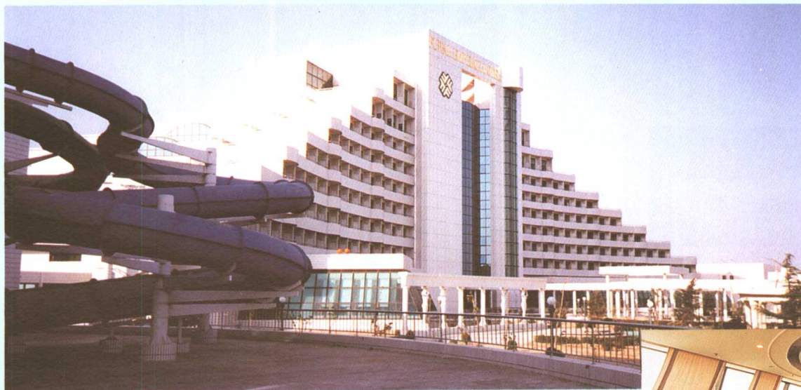
山東濰坊市富華大酒店 (全部裝修均由本公司承造)
