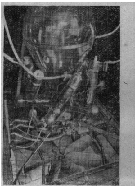
图 1-5 六极风冷式玻璃水銀整流器
