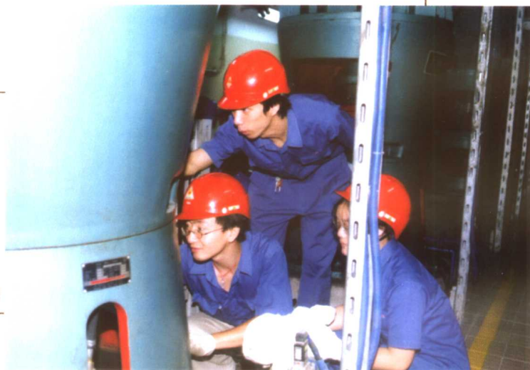
检修部员工进行设备维修
