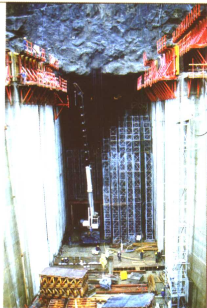
导流洞开挖施工
