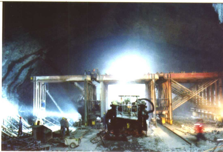
地下厂房开挖施工
