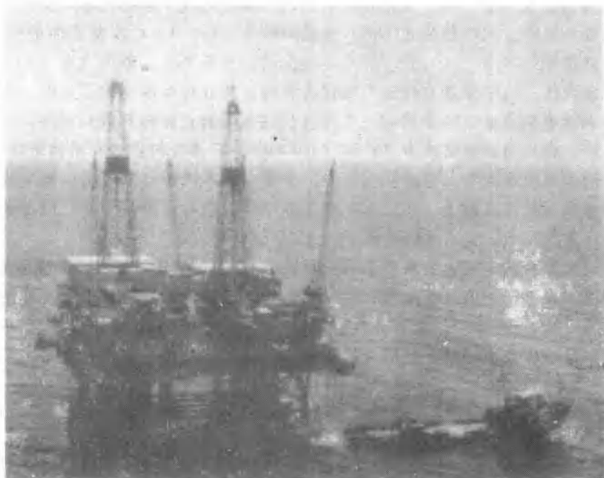
图 1.3 世界上最高的固定式近海平台，建成于1979年，位于密西西比河口的南方12英里1 025英尺深的水中。该平台重59 000吨，有62口油井
